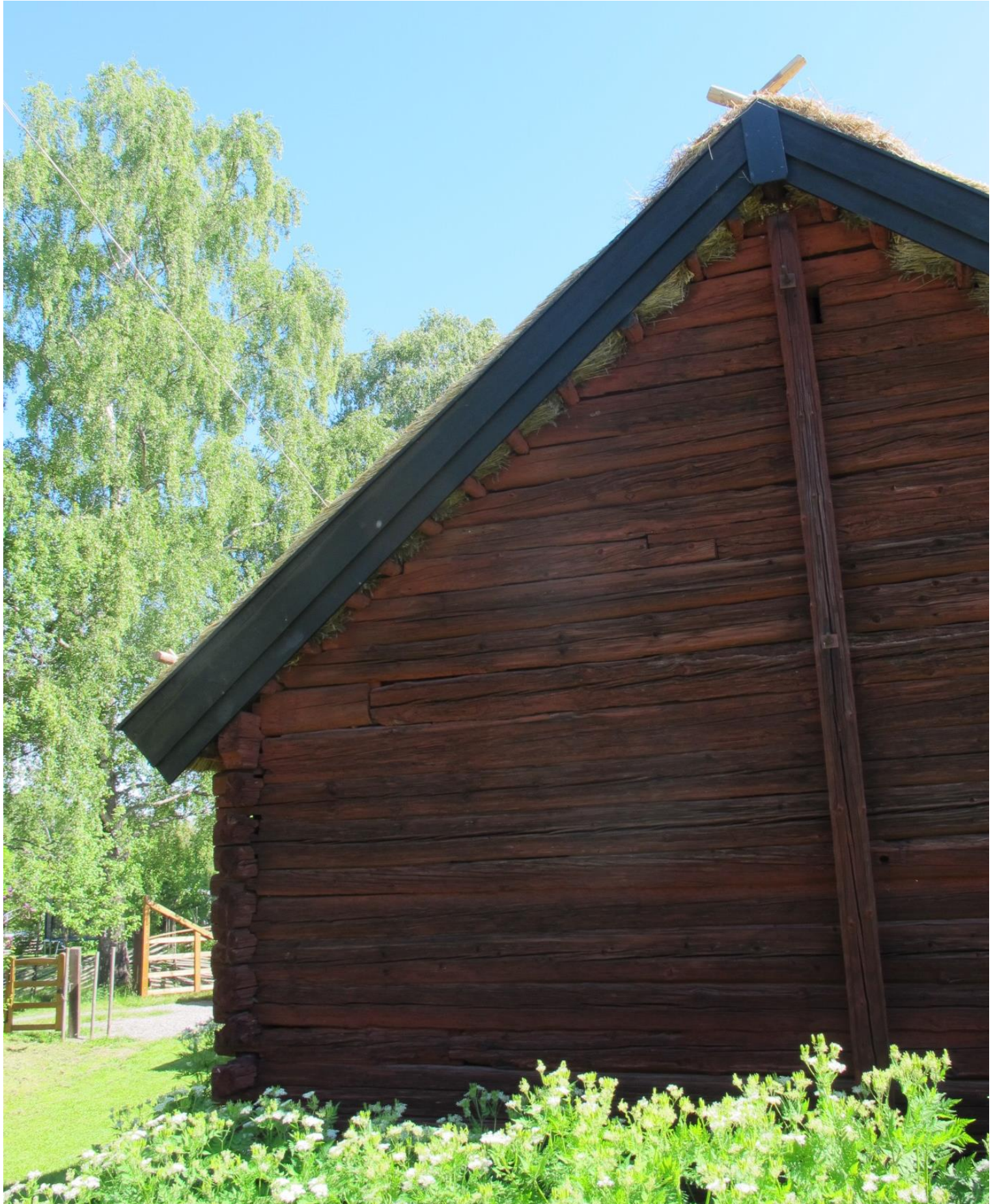
LP_2015_00116. Vindskivan skarvades för att bli högre vid takfoten t.v. i bild. Foto H. Bellberg
