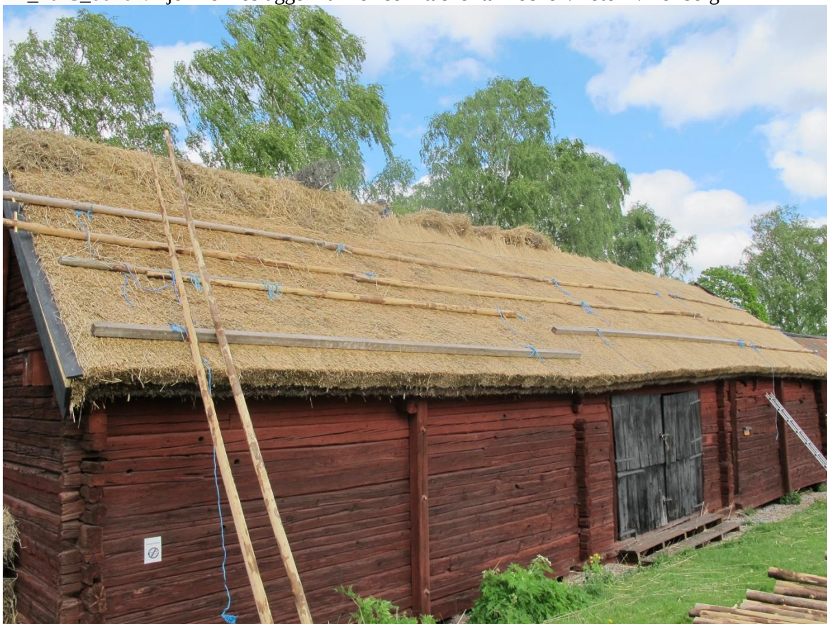
LP_2015_00108. Sydsidans nya halmtäckning. Temporärt ligger vågräta slakor. Foto H. Bellberg
